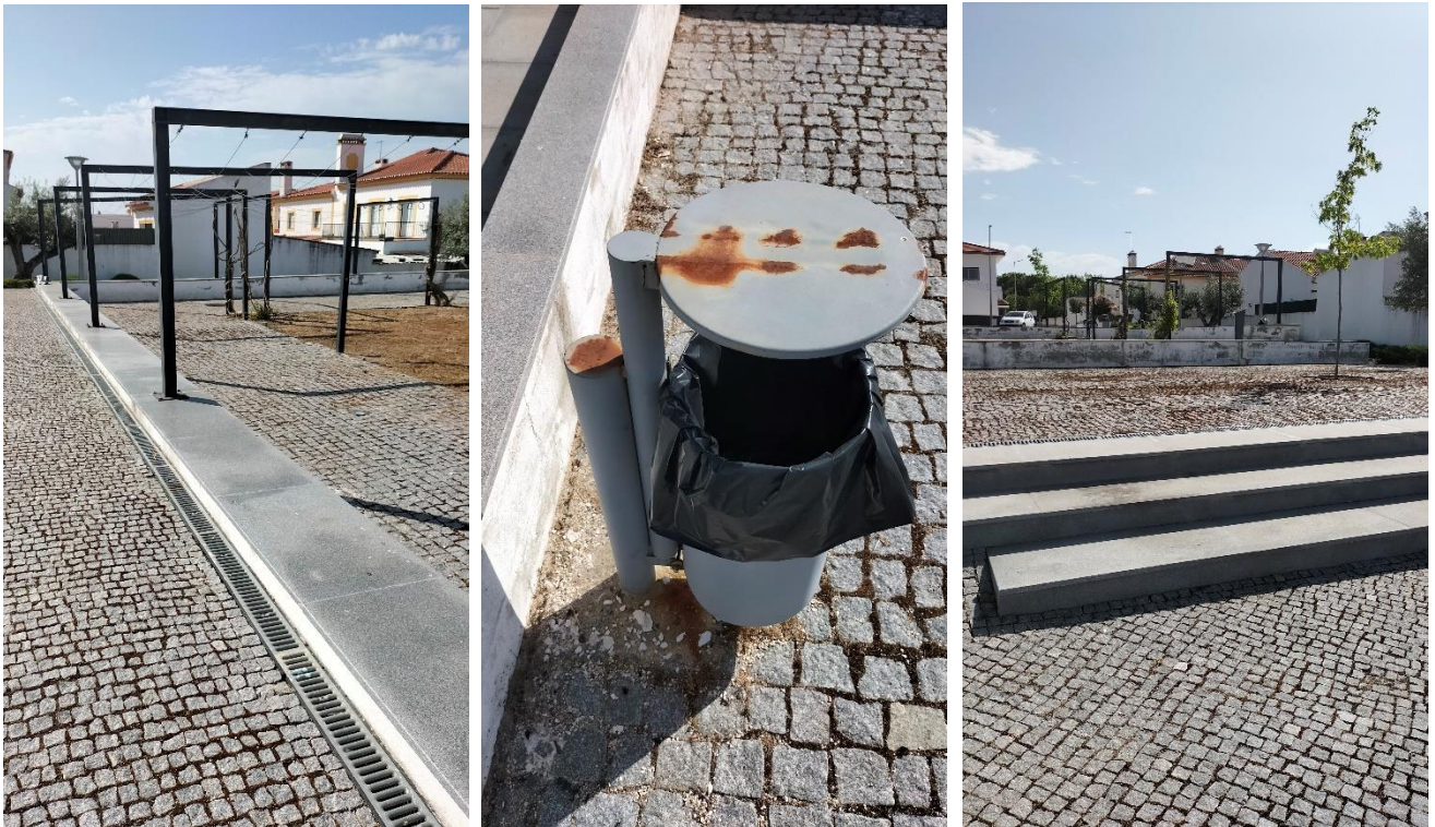
Fig. 01 – Imagens do existente
